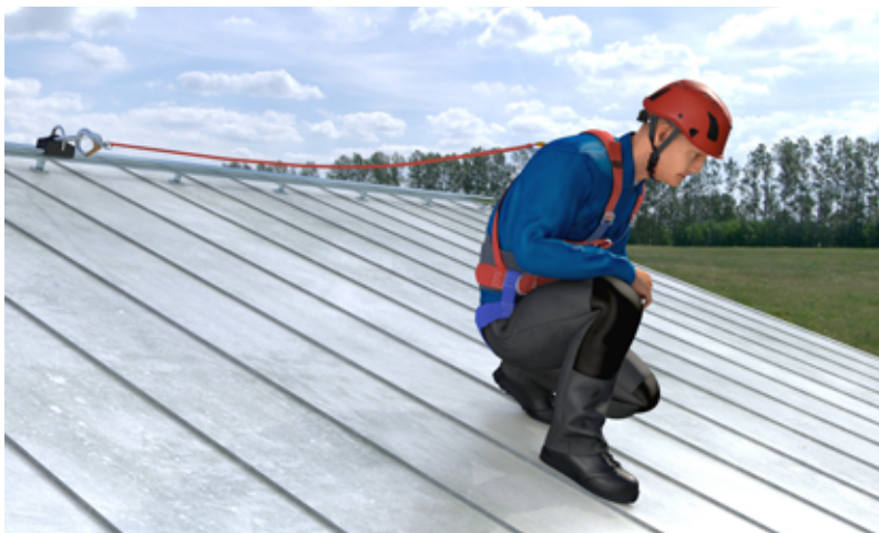
Abb. 18 Beispiel für ein Rückhaltesystem mit fester Länge, befestigt an einer Anschlageneinrichtung mit einem beweglichen Anschlagpunkt
