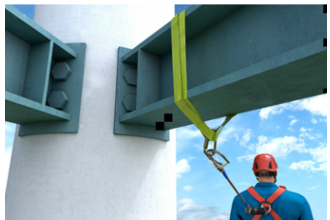
Abb. 58 Beispiel einer temporär genutzten Anschlagmöglichkeit (Stahlträger)
